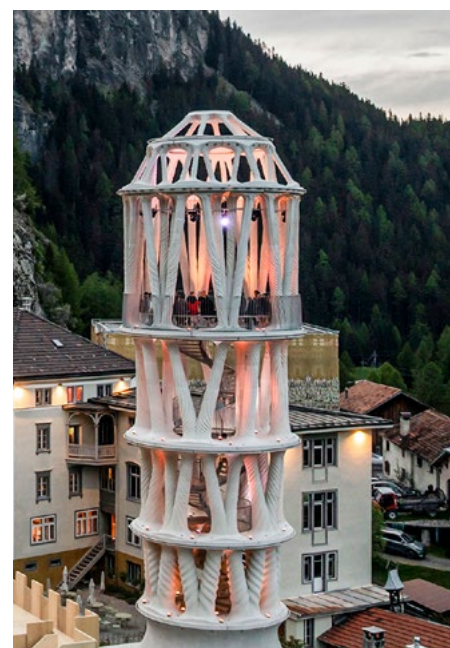
R3:shell ist eine hexagonale Holzgitterkonstruktion, die gemeinsam mit Architekturstudierenden der Universität Wuppertal entwickelt und gebaut wurde. Daneben der beleuchtete Tor Alva in der Abenddämmerung.
